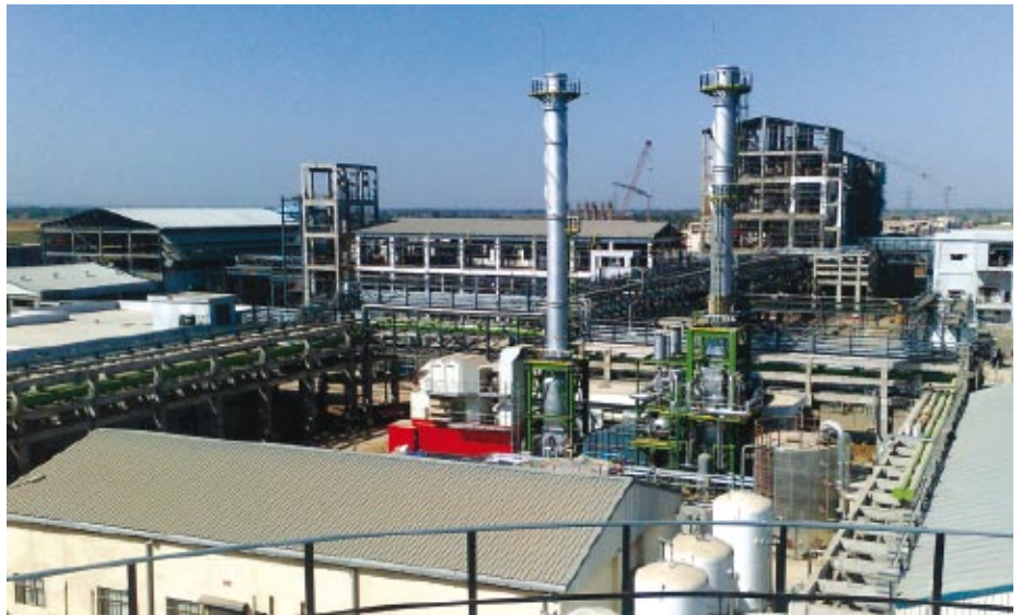
Baustelle Jhagadia: Im Bundesstaat Gujarat entsteht der größte Produktionsstandort für Lanxess in Indien. Triplan ist zusammen mit seinem Kooperationspartner Neilsoft als Gesamtplaner für die Verlagerung der Produktion von Madurai nach Jhagadia beauftragt (© Lanxess).
